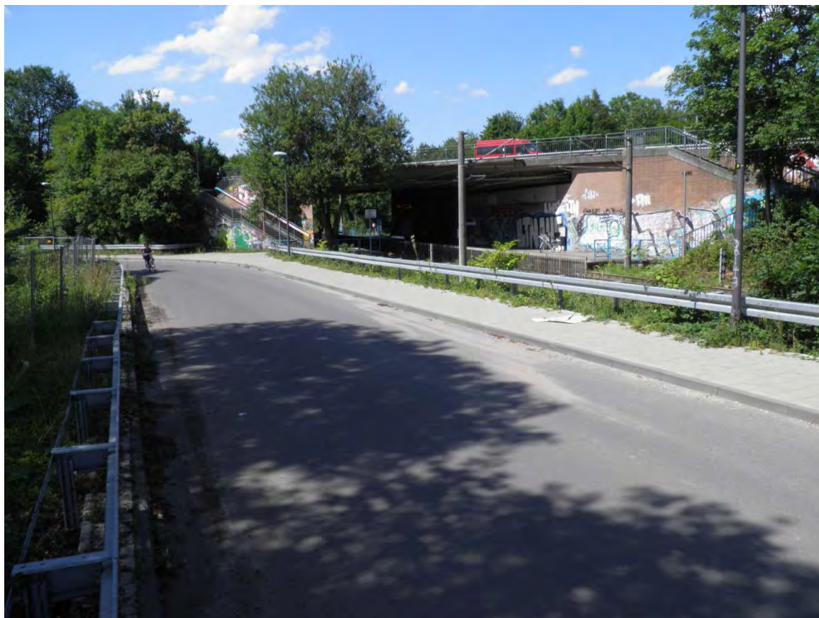
Bild 1: Erschließungsstraße neues Gewerbegebiet Westhoven, Bereich der gewünschten Bushaltestelle
